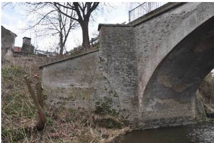
Křídlo u opěry 1 vpravo - návodní strana - je prodlouženo betonovou zeď kvůli zadržení přilehlého svahu.
