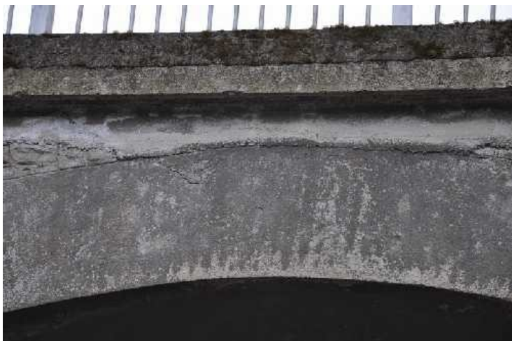
Vrchol cihelné omítnuté klenby vpravo na návodní straně.
