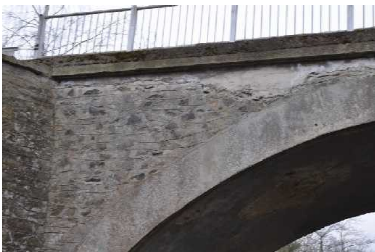
Návodní část klenby - levobřežní, bez trhlin.
