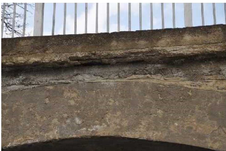
Vrchol cihelné omítnuté klenby vlevo na povodní straně.
