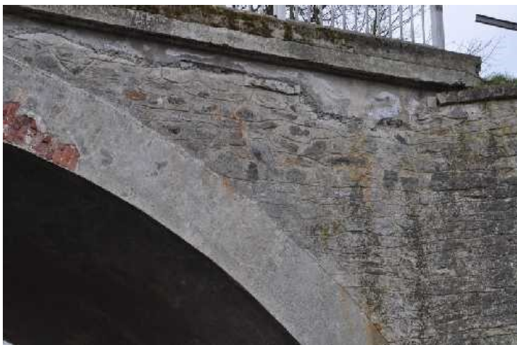
Návodní část klenby - pravobřežní, bez trhlin.
