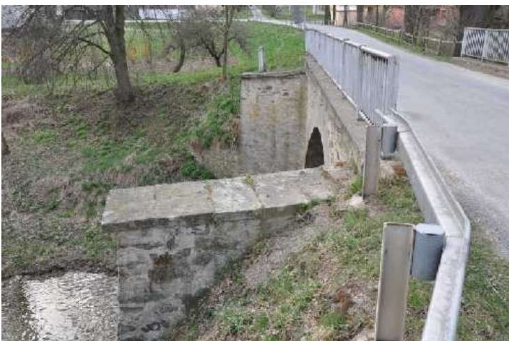
Křídlo u opěry 1 vlevo na povodní straně při pohledu shora.
