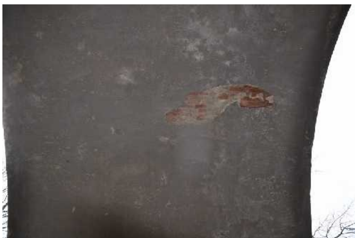
Vrchol klenby. Nebyly zjištěny žádné trhliny.
