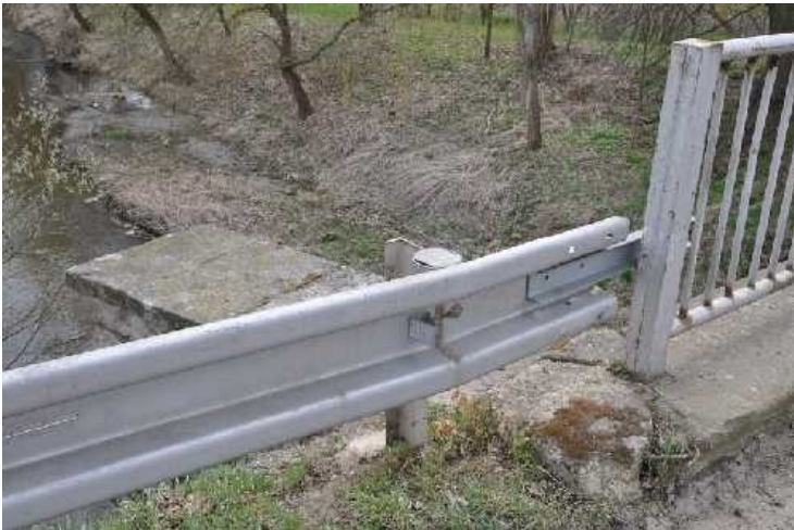
Napojení svodidlo - zábradlí vlevo.
