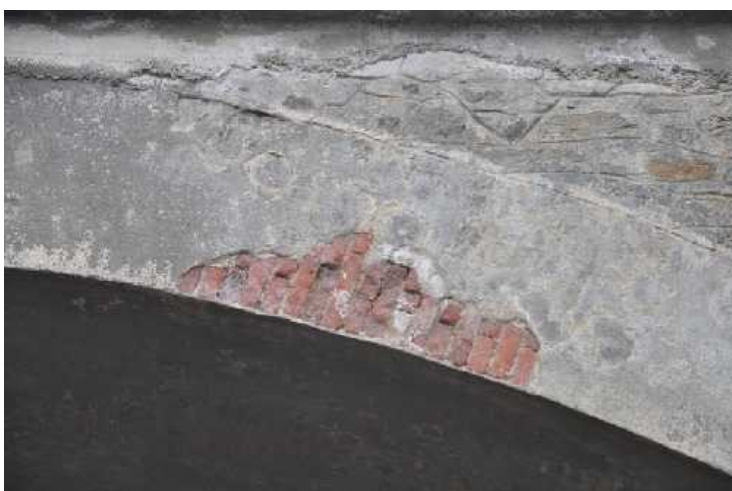
Po odpadnutí omítky vidíme průřez klenby (návodní strana vpravo).
