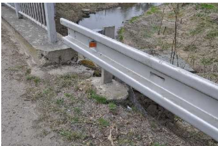
Napojení svodidlo - zábradlí vpravo.
