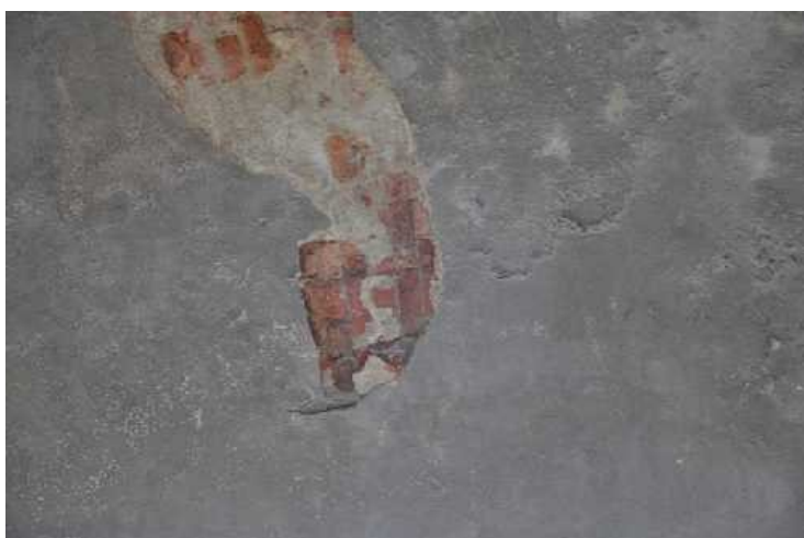
Odpadnutá omítka přímo ve vrcholu klenby.
