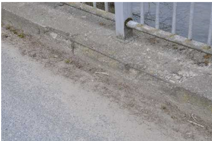
Stav římsoy a sloupek zábradlí s kotvením.
